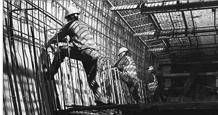
새봄을 맞아 길림성 각지는 대강건설에 팔을 걷고 나섰다. 심양으로부터 무순, 통화, 백산시를 거쳐 장백산에 이르는 심백고속철도 대강건설 길림구간에서 500여명의 건설자들이 올해 1분기 좋은 첫출발을 위하여 땀방울을 흘리고 있다. 사진은 노동자들이 터널 내부의 방수판 설치 작업을 하고 있는 모습이다.
